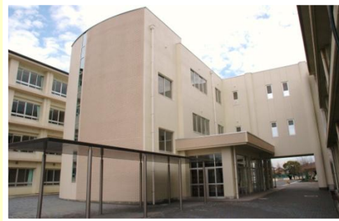
昇降口棟 平成21年3月完成
